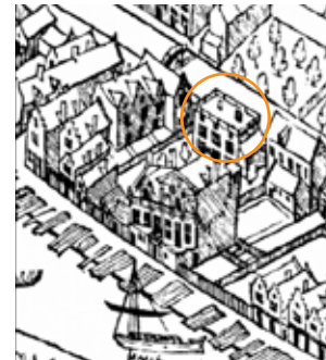
opmerkelijk plat dak (1544)
