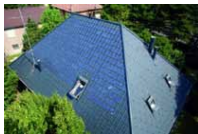
integratie in vorm en kleur, dakvlak blijft intact
