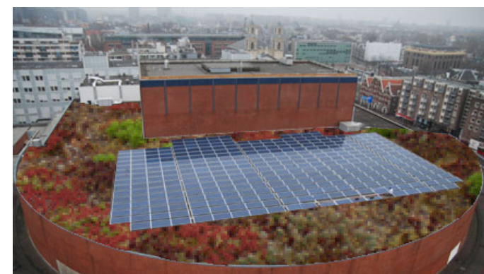
Stopera boven met zonnepanelen, onder montagefoto met groen gecombineerd
