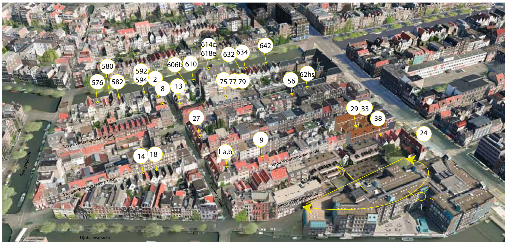
de geïnventariseerde panden in de Weteringbuurt
